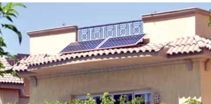
يتكون نظام **SolGuard™** من وحدات الطاقة الشمسية الكهروضوئية ذات الجودة العالمية والتي تعمل على توليد الكهرباء، بالإضافة إلى بطاريات لتخزين الطاقة، ومحول الشبكة مع محول احتياطي لتنظيم الجهد، وحماية البطاريات أثناء الشحن والتغريغ، وأيضًا، تحويل التيار المستمر إلى التيار المتردد التقليدي لتشغيل الأجهزة المنزلية.
